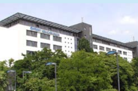
10 Gothaer Schaden-Service-Center in Berlin-Tempelhof am Teltowkanal
