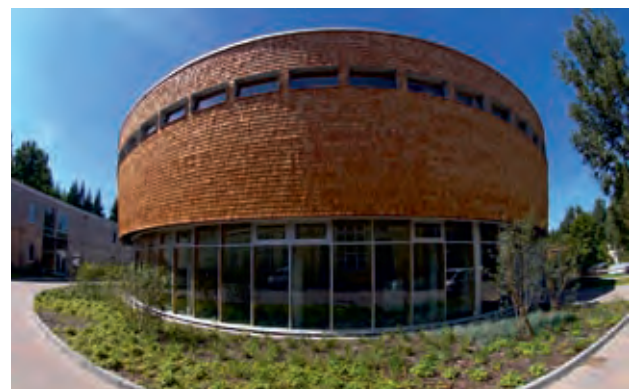
Hörsaalgebäude auf dem Waldcampus der FH Eberswalde
